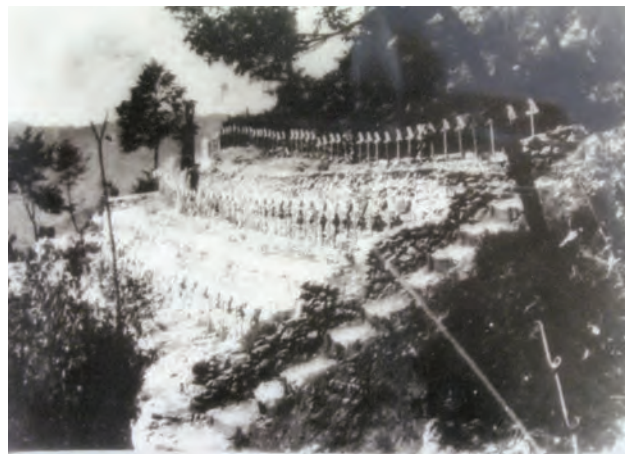
Fig. 1. Il cimitero di Cima Neutra nel 1916.
