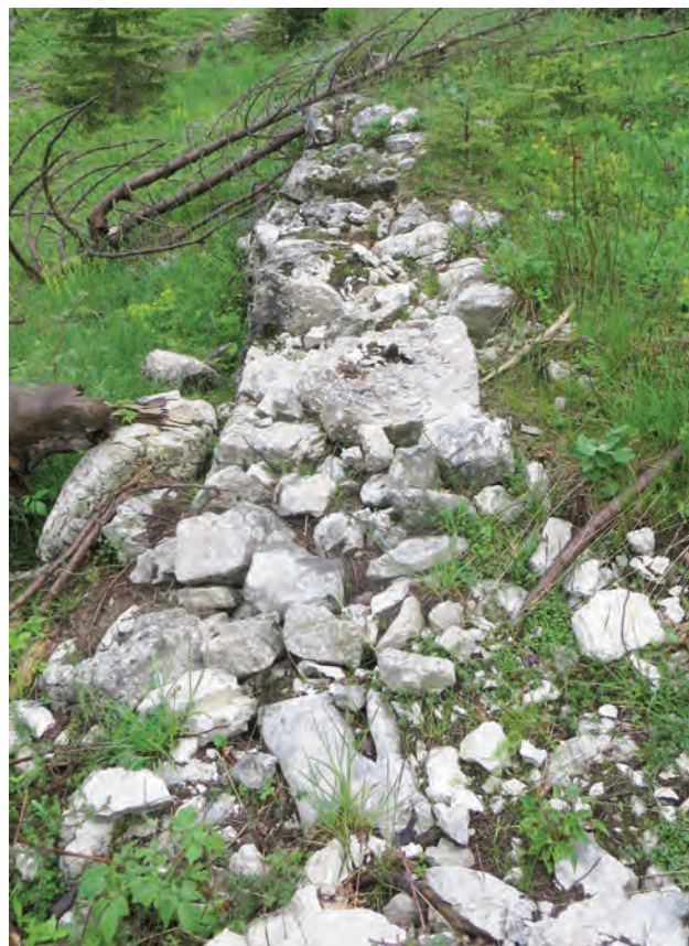
Fig. 1. Dettaglio del muretto di contenimento.
