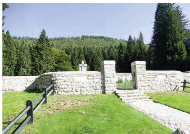
Fig. 1. L'entrata dell'area cimiteriale.
