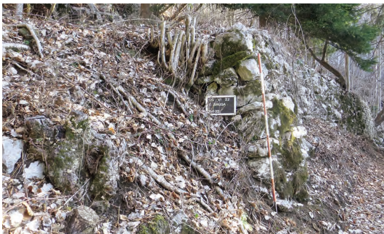
Fig. 4. Il muro di contenimento del cimitero visto da ovest.
