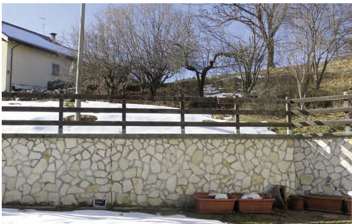
Fig. 3. Ripresa con la stessa angolazione oggi, con il muro di contenimento di recente costruzione su Contrada Campana.
