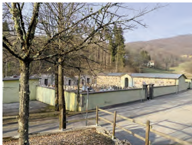
Fig. 1. Il cimitero di Fontanelle di Conco dall'esterno.
