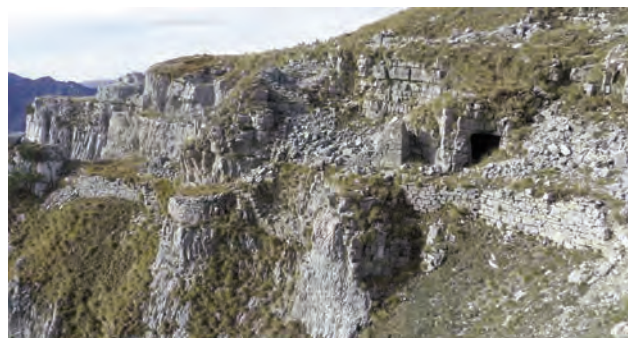
Fig. 1. Resti di infrastrutture militari lungo il sentiero dei Sogi.
