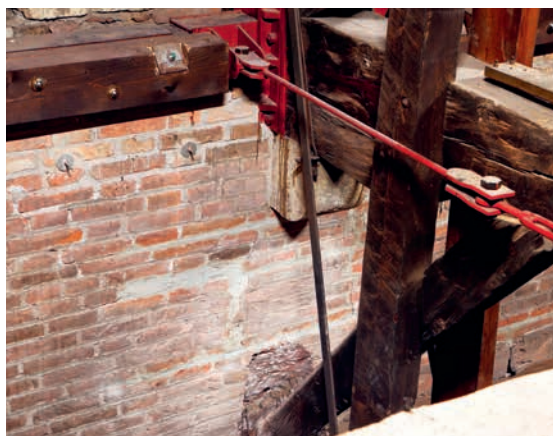
14. Riparazione localizzata della muratura in corrispondenza degli appoggi delle capriate: ristilatura armata e tirantini anti-espulsione.
