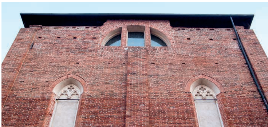
16. Inserimento di tre nuovi tiranti nella cappella della Madonna, esterno con capochiave affiancati alle paraste.
