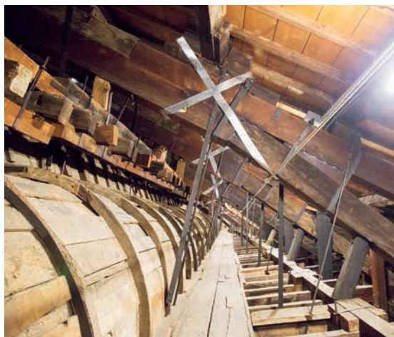
9. Rinforzo e integrazione delle connessioni tra gli elementi di copertura con zeppe in legno, viti e nastri forati
