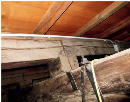
2. Particolare di alcuni appoggi degli arcarecci sui puntoni delle capriate, con zeppe e spessoramenti di forme e dimensioni varie.
