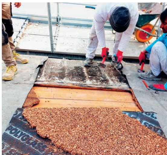
10. Smontaggio del manto in coppi con rinvenimento strato di malta di fissaggio sottocoppo e pannelli di sughero incollati alla guaina esistente.
