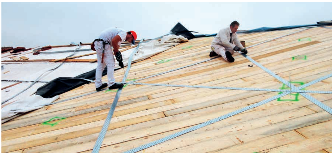
11. Posa del tavolato inclinato a 45° e successivo fissaggio dei nastri forati in acciaio (notare l'evidenziazione dei punti di integrazione delle connessioni tavolato/arcarecci/capriate con viti).
