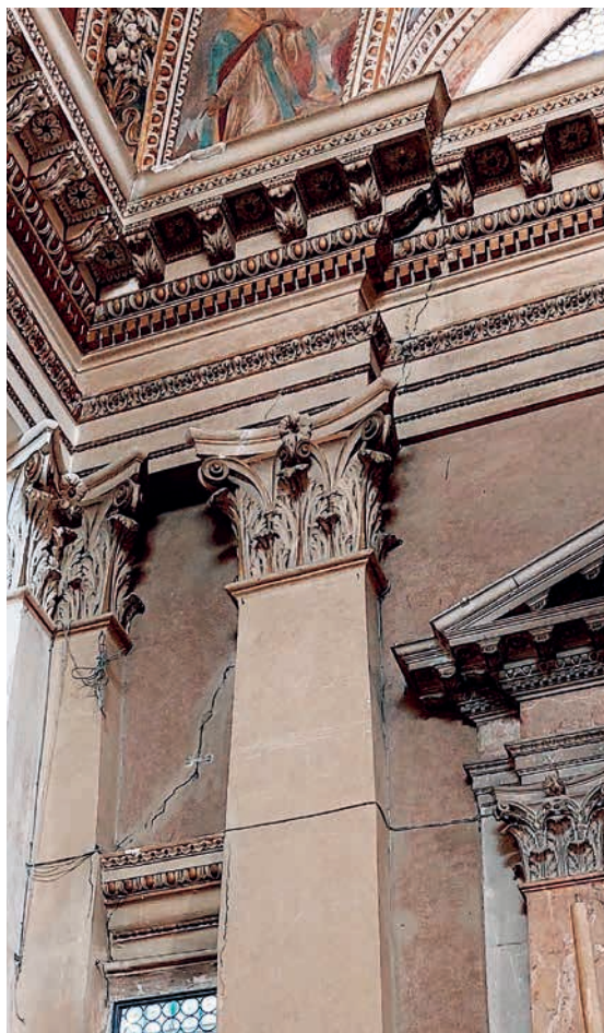
3. Particolare dello spigolo interno della cappella della Madonna; si nota l'evidente lesione che parte dalla finestra termale sopra la cornice sommitale e scende fino a terra.
