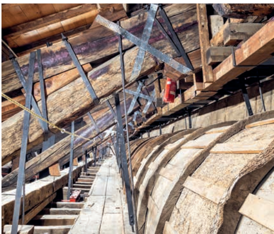
8. Rinforzo e integrazione delle connessioni tra gli elementi di copertura con zeppe in legno, viti e nastri forati.
