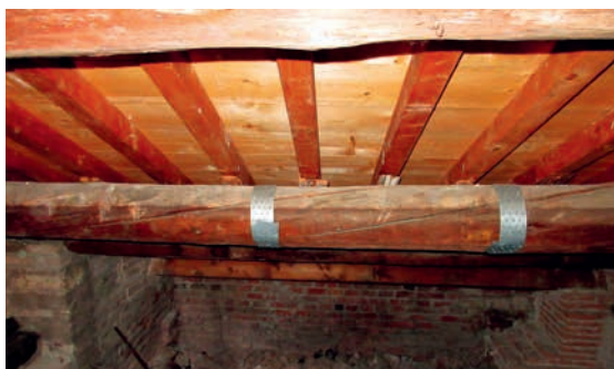
18. Consolidamento di elementi lignei con fasciatura con nastro forato in acciaio.
