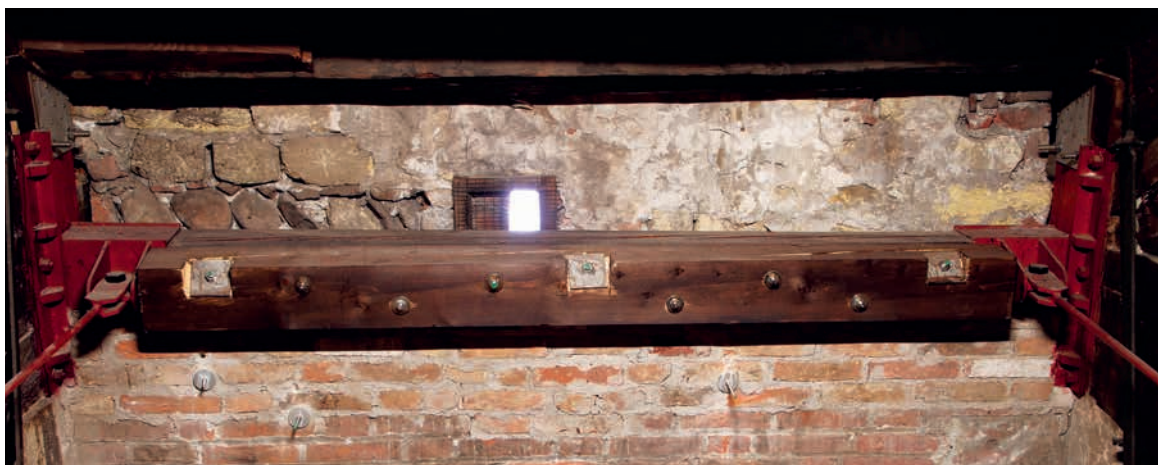
12. Inghisaggio correnti lignei di bordo nella muratura e inserimento di tirantini passanti di rinforzo della stessa, sottotetto navata.
