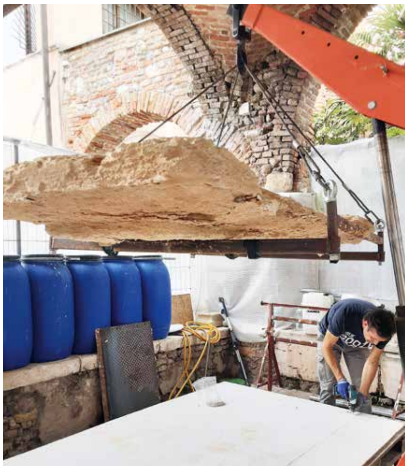
Fig. 16. La delicata fase di movimentazione del coperchio preliminare al consolidamento a immersione.
