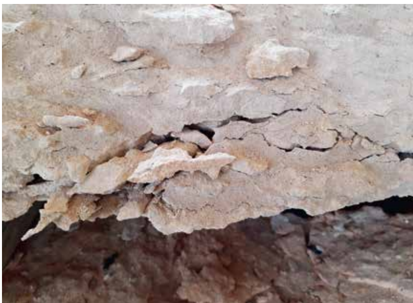
Fig. 5. Dilatazione: fratture e distacco di parti.
