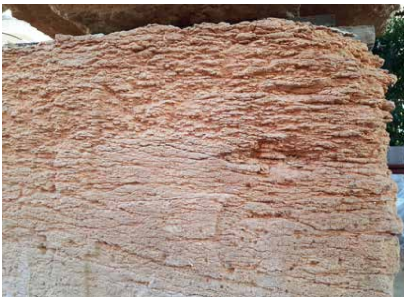
Figg. 8, 9. Disgregazione ed esfoliazione.
