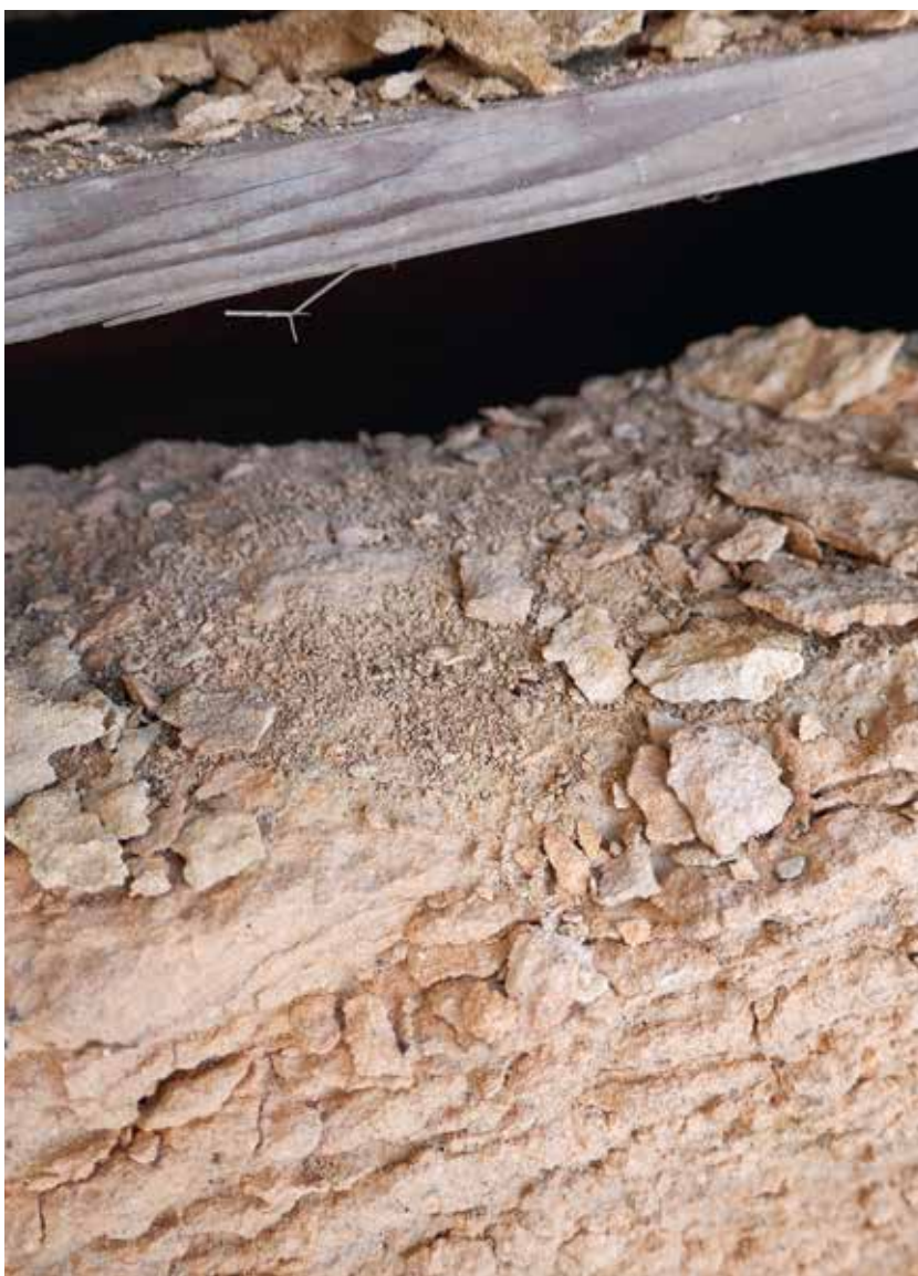
Fig. 6. Idrolisi: esfoliazione e polverizzazione.
