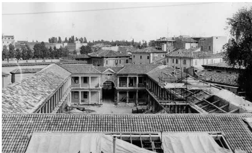
11. Vista dall'alto della copertura, durante i lavori in corso nel 1981. A destra si può vedere l'orditura del tetto (Archivio fotografico SABAP VR RO VI).
